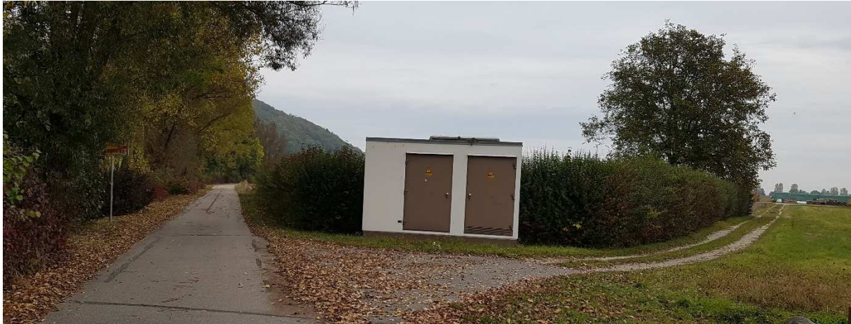
Blick von der Straße „Moosgraben“ in Richtung Nordosten auf die bestehende Trafo-Station, rechts: bisherige Gewerbefläche/ Planungsflächen, links: Ufergehölze entlang des Moosgrabens, Hintergrund: private Gartenfläche
