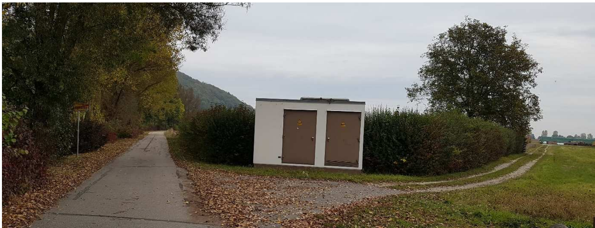
Blick von der Straße „Moosgraben“ in Richtung Nordosten auf die bestehende Trafo-Station, rechts: bisherige Gewerbefläche/ Änderungsflächen, links: Ufergehölze entlang des Moosgrabens, Hintergrund: private Gartenfläche
