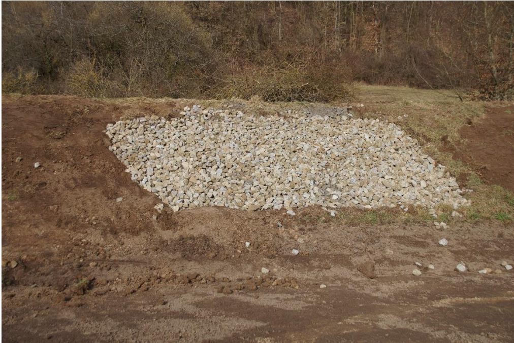
Fertiges Schotterfeld bei Frengkofen
