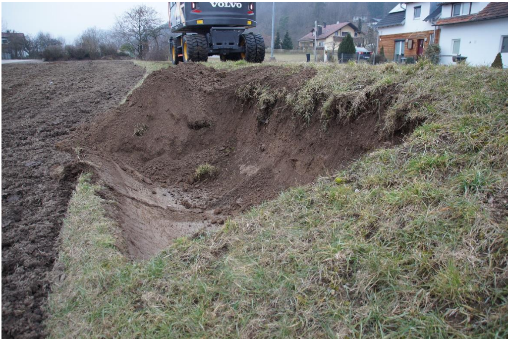
Kein Schotter im Bahndamm ....
