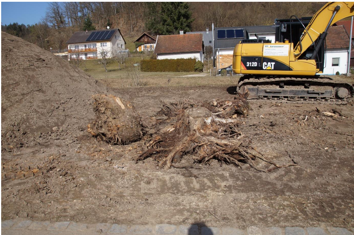
Wurzelstöcke wurden stellenweise in die Schotterfelder integriert – hier entstehen zusätzliche Hohlräume und Reptilienquartiere
