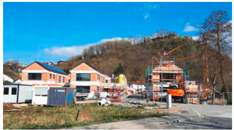
Auch die Arbeiten im Baugebiet Bayerwaldstraße laufen auf Hochtouren.
