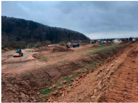
Die Arbeiten zur Erschließung des neuen Baugebietes in Sulzbach wurden nach der Winterpause wieder aufgenommen. Die zukünftige Straßenführung ist bereits erkennbar.
